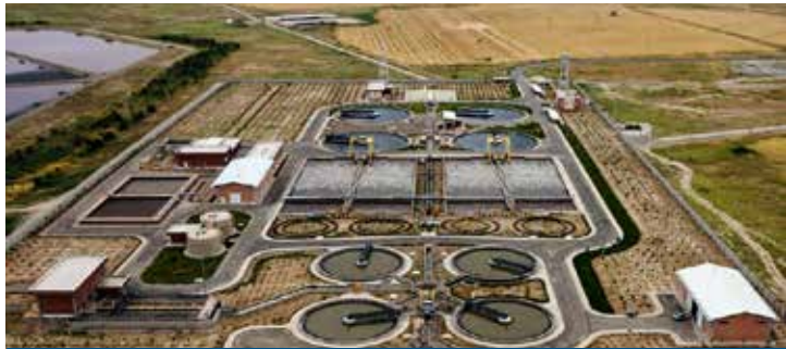
Станция очистки сточных вод Аль-Теймур. Мешхед
