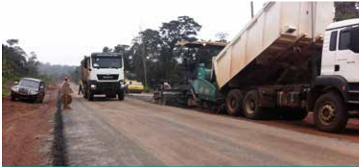
Дорога Сангмелима – Бикула. Камерун
