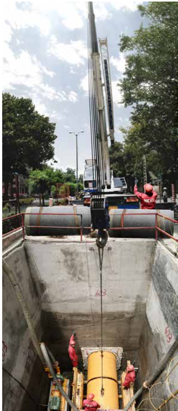
Хамаданская канализация (выполнена методом домкратирования труб)
