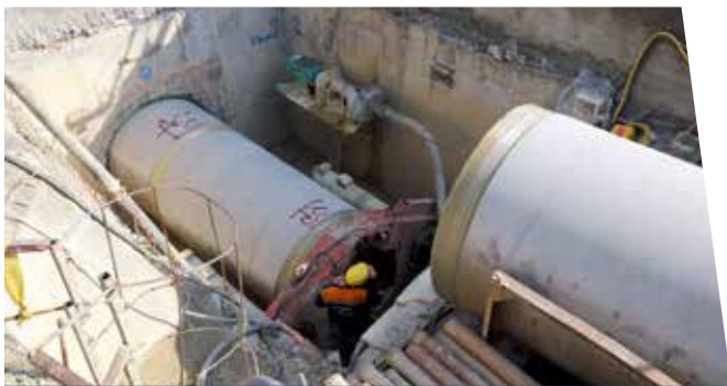
Укладка трубопровода канализации Ахваза и Каруна
