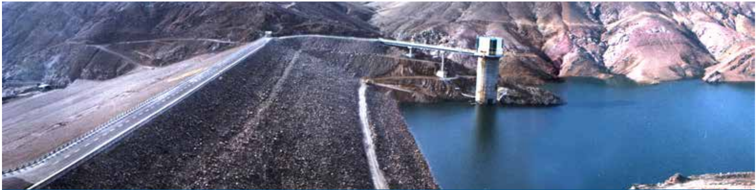
Земляная плотина Саттархан (Ахар) и сопутствующие сооружения
