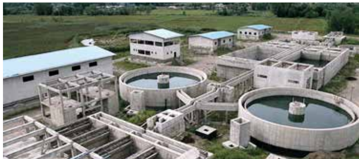
Водоочистная станция. Анзали
