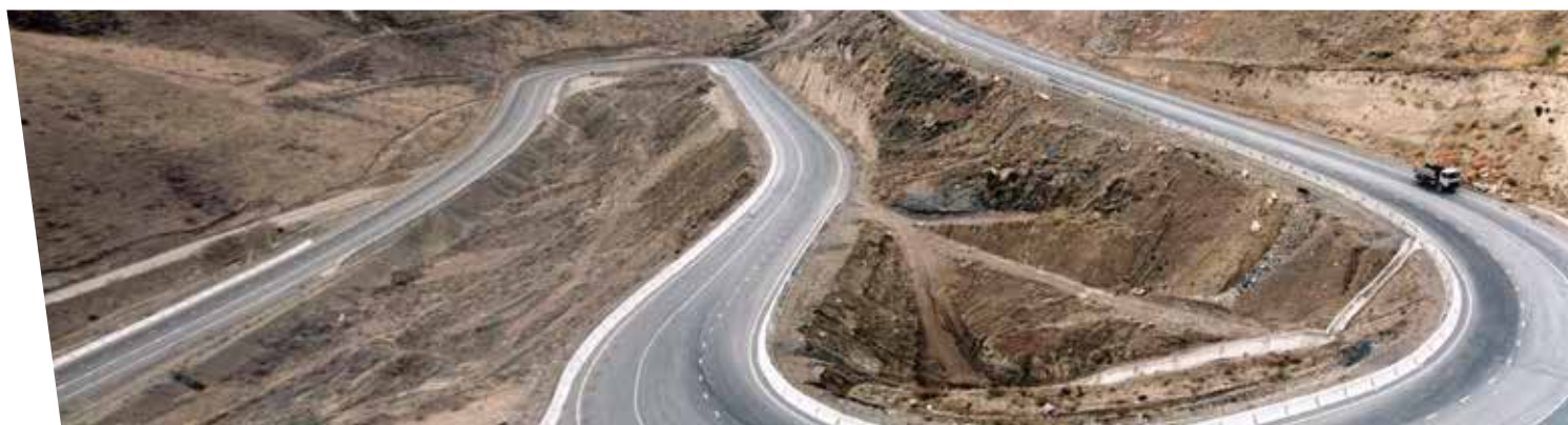
Реконструкция и расширение дороги Бишкек – Ош. Киргизстан
