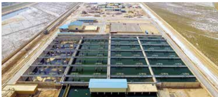
Водоочистные сооружения. Ахваз
