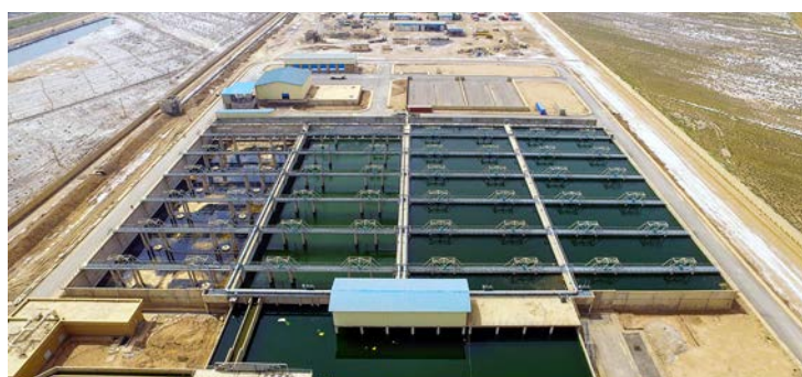
مصفاة الصرف الصحي شرق اهواز (منجز)
