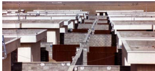
مشروع سكنية ٤٠٠ وحدة للعمال مصنع الاسمنت درود
