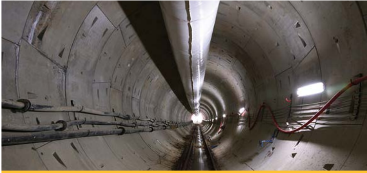
مشروع القطار المدني اهواز ( قيد التنفيذ )
