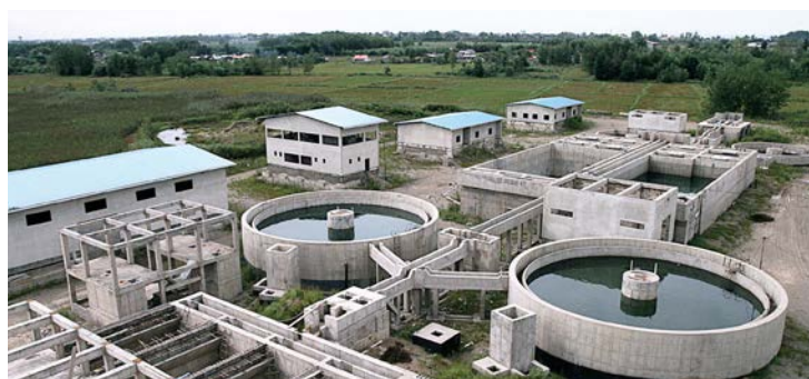
مصفاة الصرف الصحي بندر انزلي ( قيد التنفيذ )
