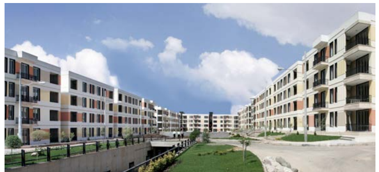
مشروع ٥٥٢ وحدة سكنية مدينة جديدة برند (منجز)
