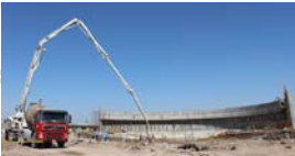
■ مشروع مصفاة وشبكة نقل المياه - الكفل
