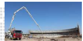
پروژه تصفیه خانه و شبکه انتقال آب الکفل
