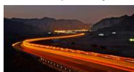
احداث پل روی مسیر بنی سوق در ولایت رستاق
